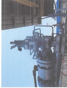
รูปอุปกรณ์ควบคุมความดันก๊าซเกินขีดเบี่ยงเบนระยะ
